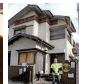
▲古民家を改装した居酒屋「凡場」
